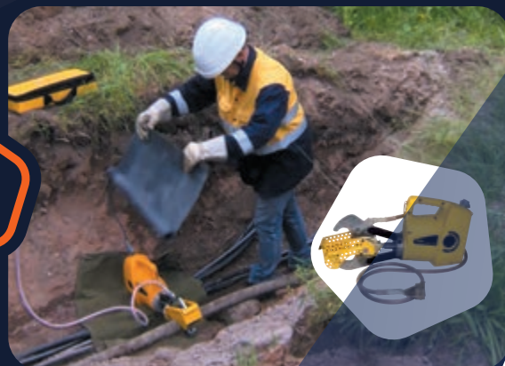
Verificación de la ausencia de tensión con total seguridad
